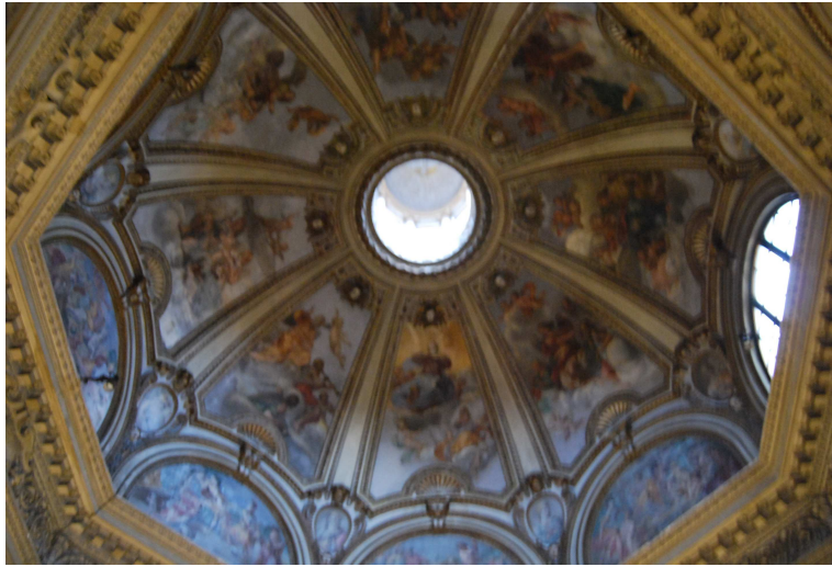
Fig. 9 Decorazione parietale della cupola impostata sull'ottagono, preceduta da lunette e scandita dalle vele
