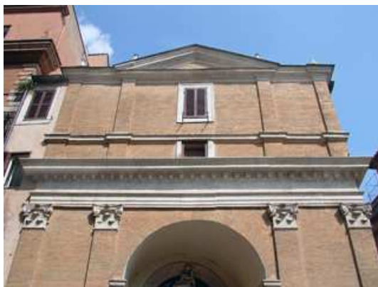
Fig. 2 Particolare del prospetto diviso in due ordini: trabeazione, attico e coronamento con timpano centrale triangolare.
